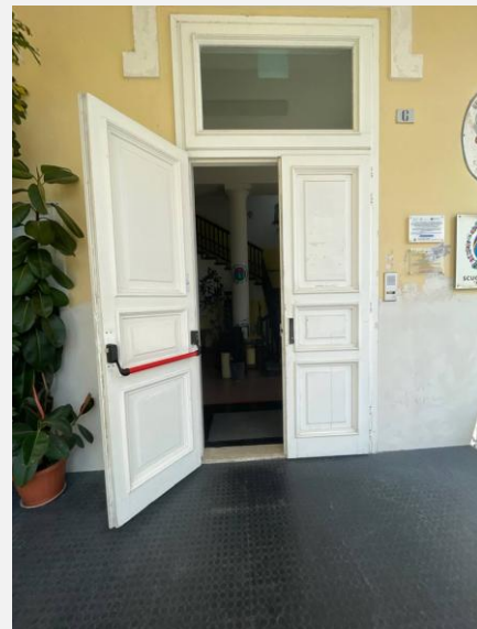
Gradino di 2,5 su ingresso principale
