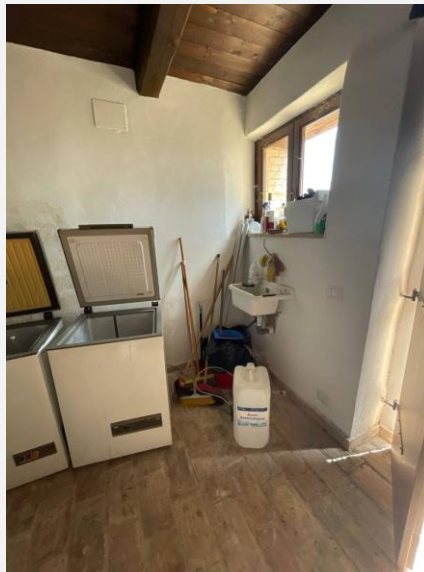
Sala al piano terra e intero edificio sprovvisto di bagno riservato a persone con disabilità, la struttura viene utilizzata durante eventi comunali (feste)
