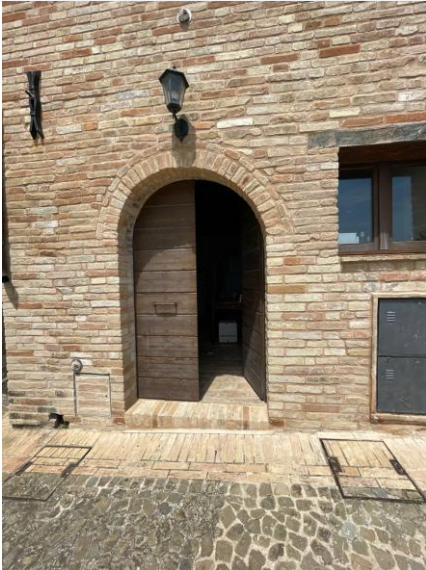
Accesso stanza piano terra con dislivello di 10 cm
