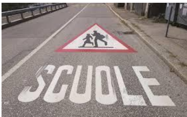
Figura 16 Segnaletica orizzontale - zona frequentata da bambini (es. scuole)
